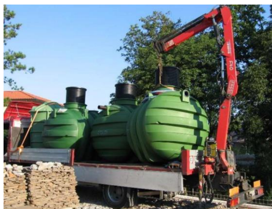
Fot. 1. Prawidłowy transport i rozładunek zbiorników
