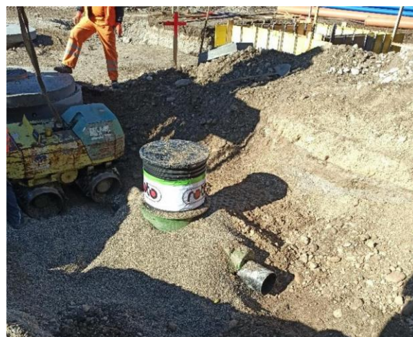
Fot. 4. Zbiornik obsypany żwirem 4/16 mm
