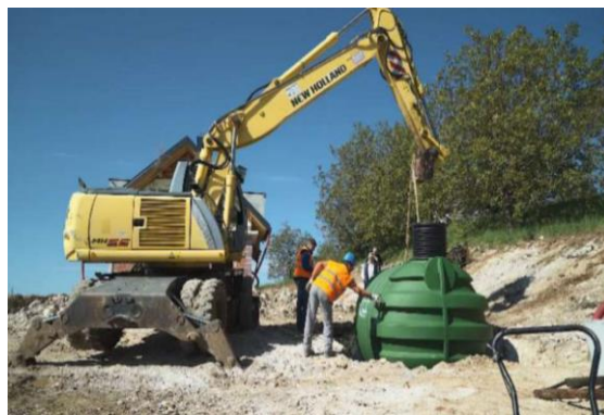
Fot. 3. Montaż zbiornika
