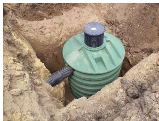
Fot. 4. Posadowiony zbiornik
