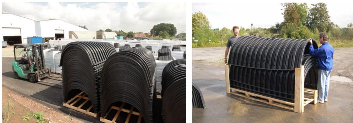
Zdjęcie 1: Transport elementów tuneli na paletach. Zdjęcie 2: Zdejmowanie elementów ze stosu.
