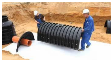
Zdjęcie 8: Wykonanie wlotu/
