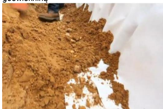
Zdjęcie 10: Przykrywanie rzędów tuneli geowłókniną
