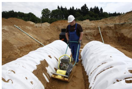
Zdjęcie 12: Zagęszczanie gruntu pomiędzy tunelami
