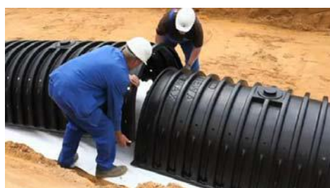
Zdjęcie 9: Łączenie tuneli.
