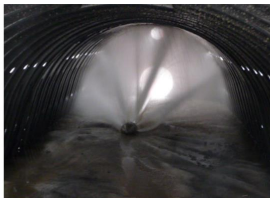
Zdjęcie 4: Głowica płucząca w trakcie czyszczenia.
