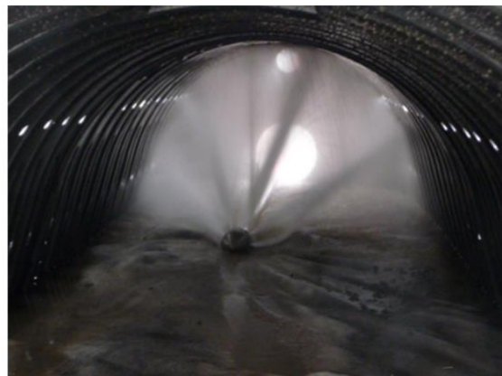
Zdjęcie 15: Czyszczenie wysokim ciśnieniem
