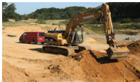
Zdjęcie 5: Wykonywanie wykopu.
