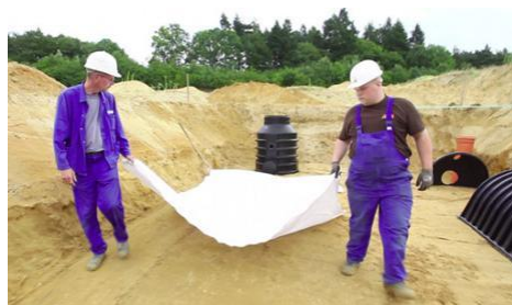
Zdjęcie 7: Geotkanina na dnie wykopu.
