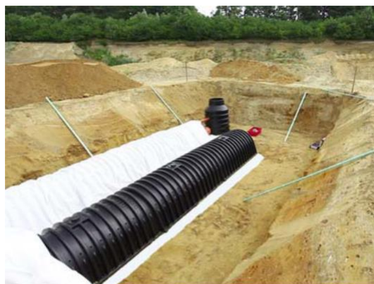
Zdjęcie 10: Przykrywanie rzędów tuneli geowłókniną
