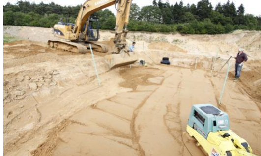
Zdjęcie 13: Przykrywanie elementów tuneli
