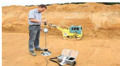
Zdjęcie 6: Badanie gruntu metodą płyty dynamicznej.
